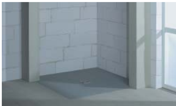
Bild 3: Barrierefreie Duschanlage (Werkbild Illbruck)
