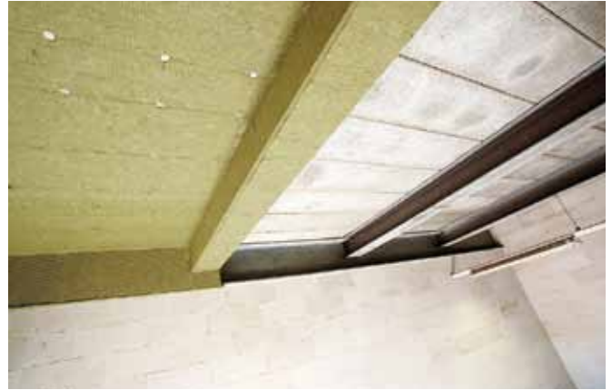
Erhöhung der Feuerwiderstandsdauer von Betondecken
