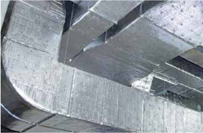
Lüftungsleitungen EI 90-S
