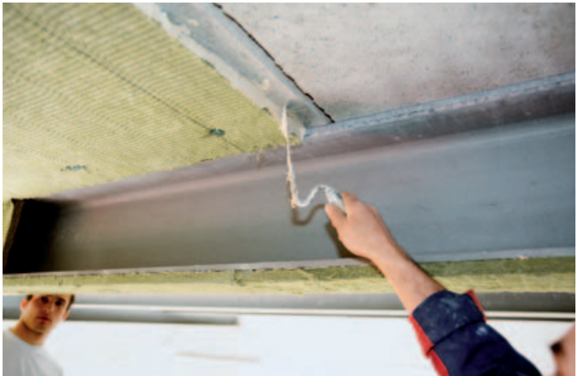
Verklebung der Stöße an den Steelprotect Boards
