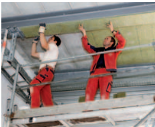
e) Aufbringen der Brandschutzbekleidung am Untergurt.
