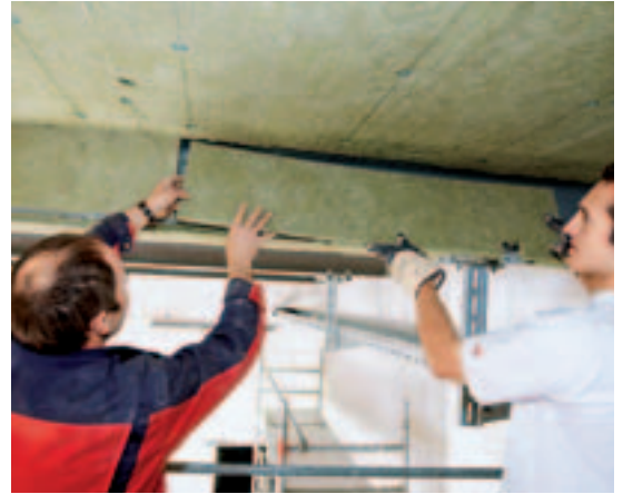
b) Einbringen der Knaggen – hier hat der Verarbeiter selbst eine vollflächige Hinterlegung gewählt.
