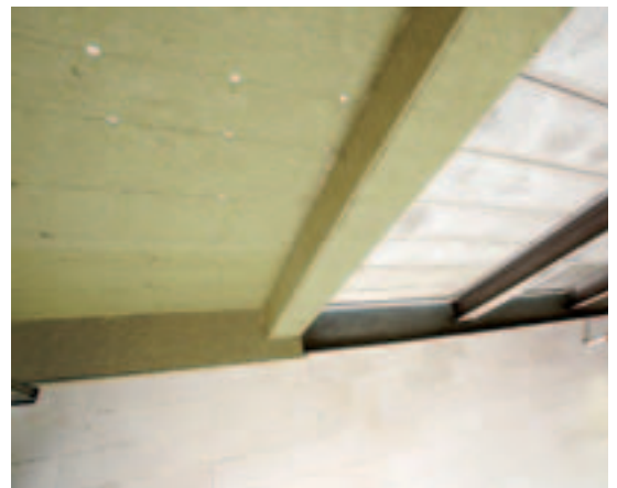
f) Fertige Trägerbekleidung.
