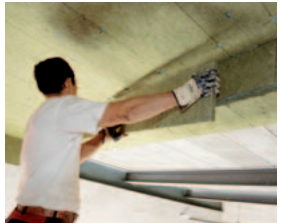
d) Aufbringen der Brandschutzbekleidung am Seitenflansch.
