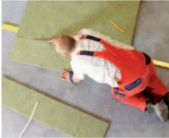
a) Zuschneiden der Platten
