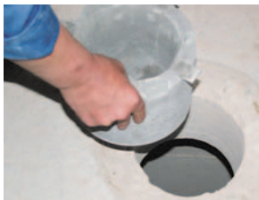
Bild 33 Einsetzen des ACO FIT-IN Einbausets
