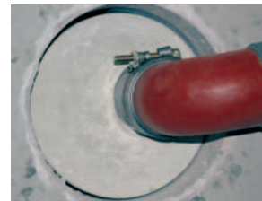
Bild 35 Anschluss der SML-Rohrleitung
