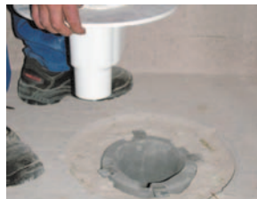
Bild 34 Einsetzen des WAL®-SELECTA
